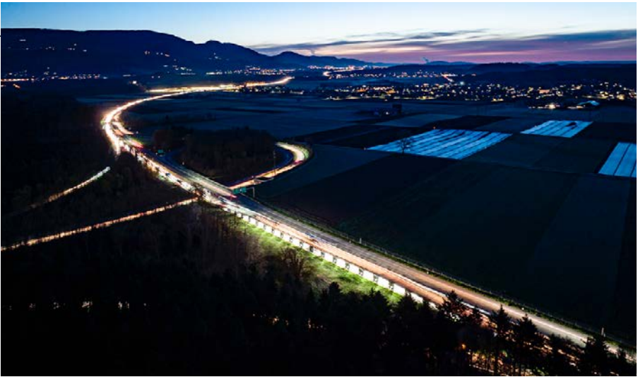
Die ASTRA Bridge auf der A1. Unter der Brücke wird die Autobahn saniert, während der Verkehr darüber fliessen kann. Waren zu Beginn die zu steilen Rampen ein Problem, funktioniert dies jetzt dank verlängerten Rampen mit verringerten Neigungswinkel sehr gut.
