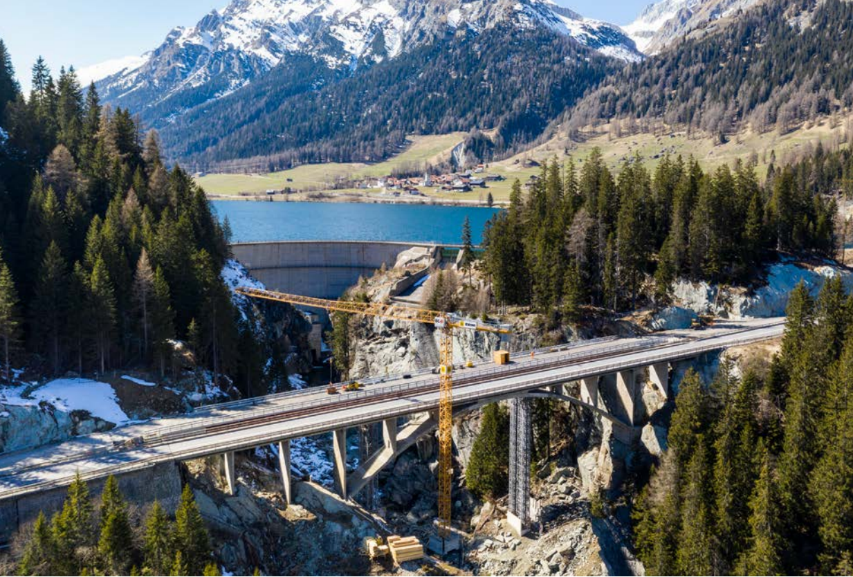
Die Crestawaldbrücke der Nationalstrasse N13 im Rheinwald bei Sufers während Sanierung und Ausbau 2017–2023.
