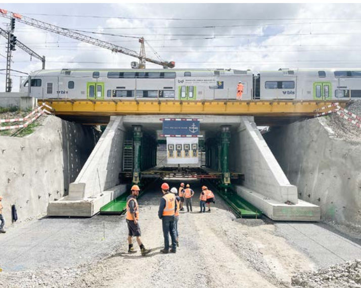
Neue Entlastungsstrasse Nord, Münsingen. Einschub neue Unterführung unter Bahntrasse. Leistungen b+d: Gesamtplaner und Fachplaner Phasen 31–53, Bauleitung, Bauvermessung, Monitoring Baugrube
