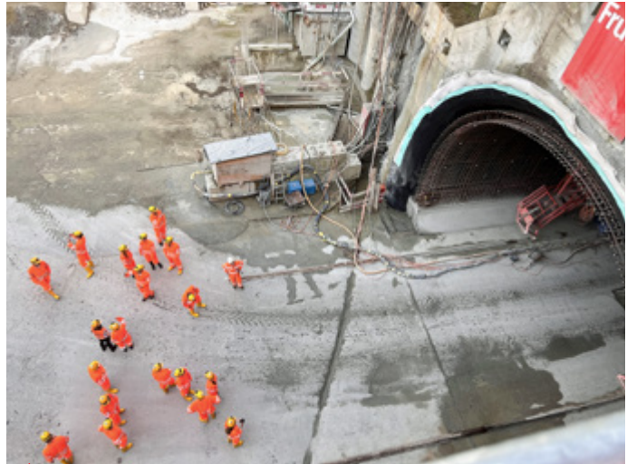
Die Baugrube im Wildpark
