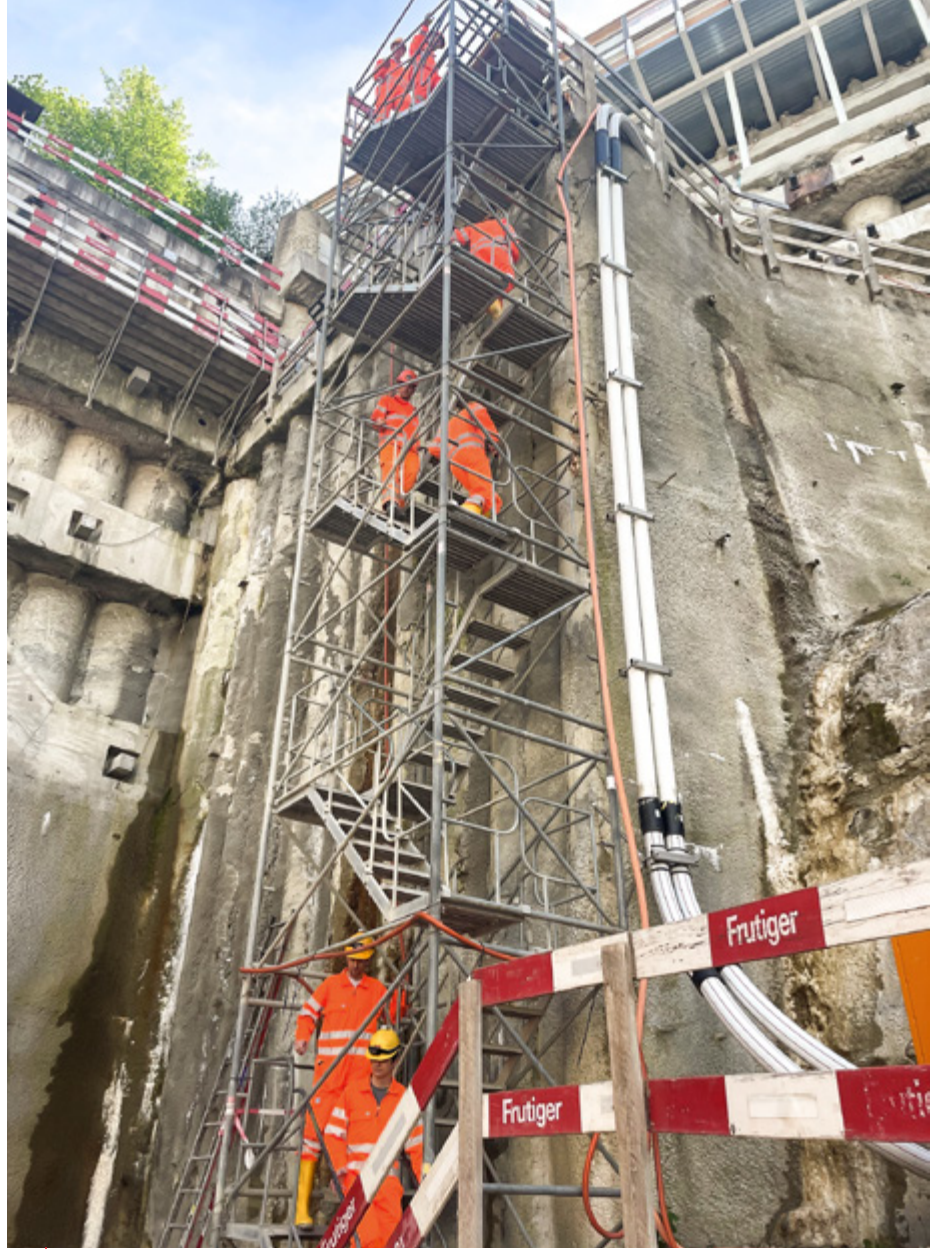
Abstieg zur Baugrube
